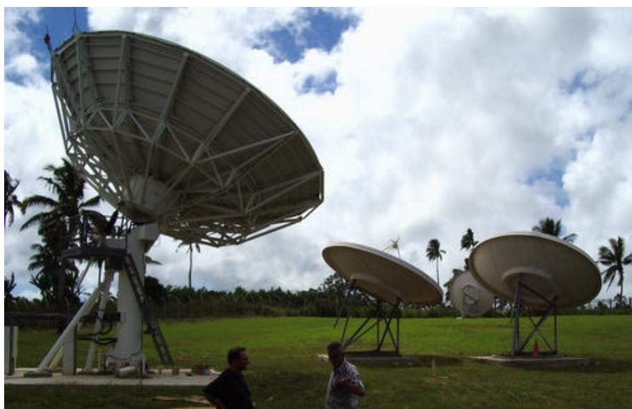
Il Centro di Controllo TLC della TonFon, la RAI/Telecom Tongana
